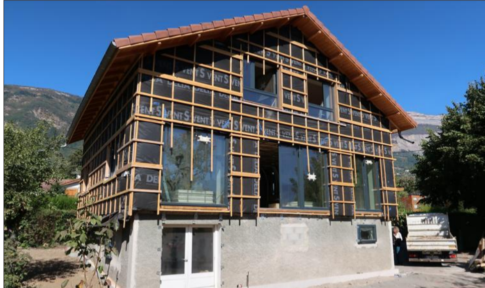
À La Tronche, cette maison sera isolée thermiquement par l'extérieur avec des panneaux en laine de bois.
